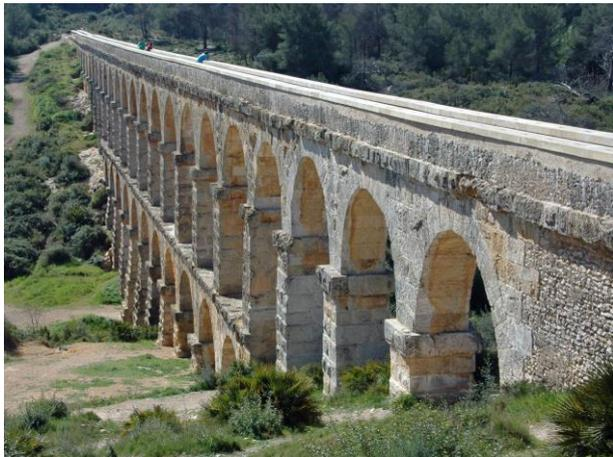
Das imposante, zweistöckige Bauwerk ist 270m lang und 26m hoch. Die untere Reihe hat 11 Bogen und die obere hat 25 Bögen. Oben ist die gut erhaltene Wasserrinne. Der römische Aqueducte wird auch als „Ponte del Diable“ bezeichnet.
